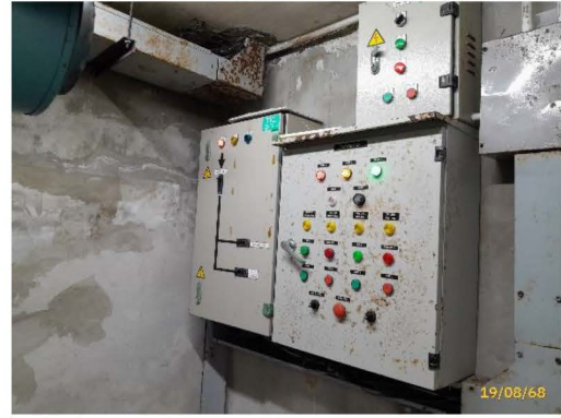
ตู้ควบคุมระบบปั๊มน้ำใช้
