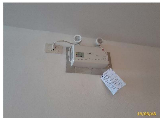
Battery ไฟฟ้าสำรอง
